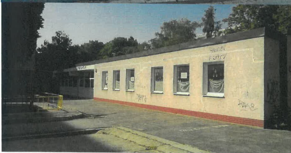
Stavba súpisné číslo 13507 na Čiližskej 26A v Bratislave - stav k 18.5.2020
