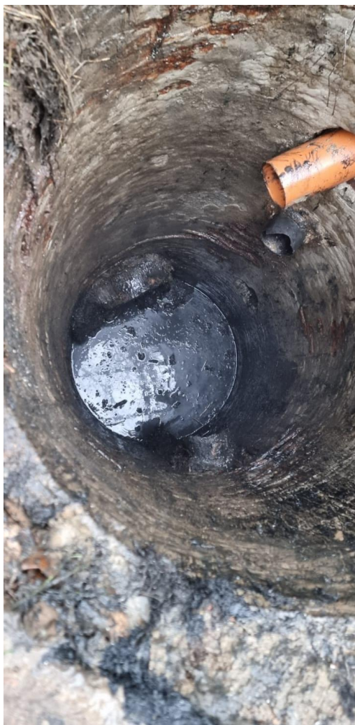
Vyčistená kanalizačná šachta
