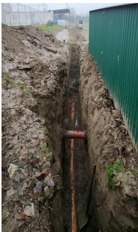
Kanalizačná prípojka v spáde
