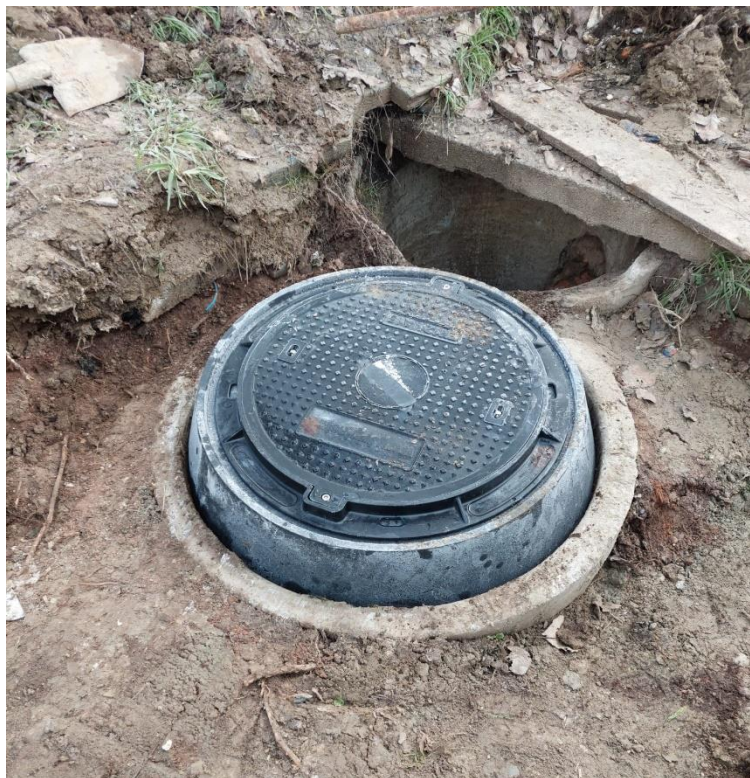
Nový poklop na šachte, druhý bude doplnený (komplikovaný terén, hrozí zosuv okolitej zeminy)
