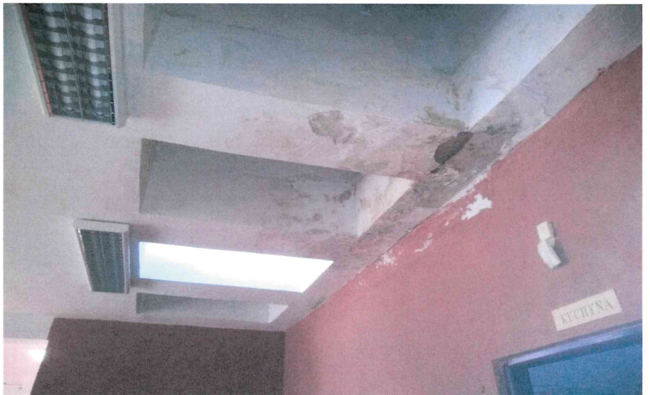
Objekt Vážská 34 Bratislava - rok 2021
