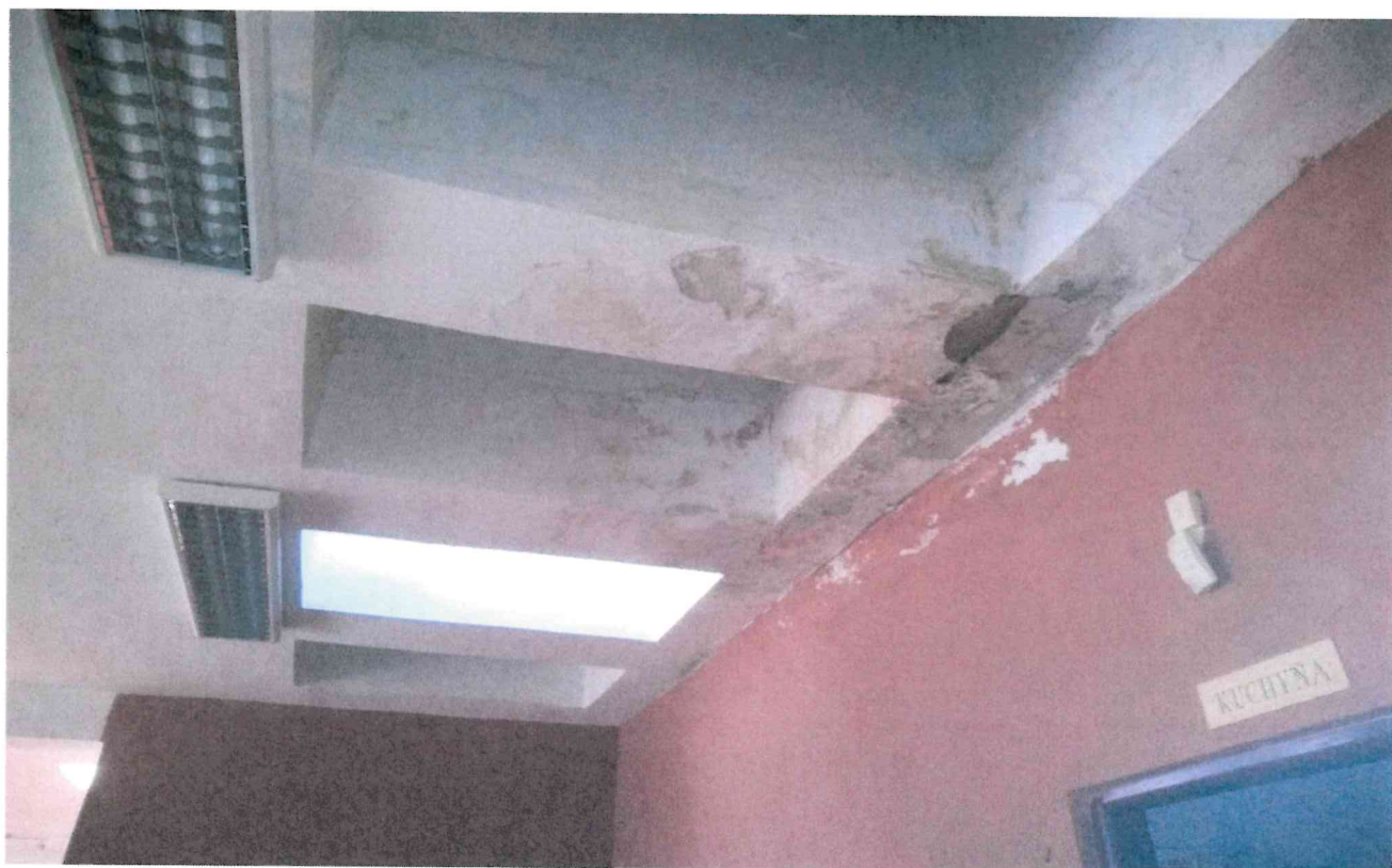
Objekt Vážská 34 Bratislava - rok 2021
